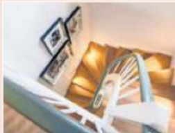
Der originale Treppenaufgang bietet reichlich Platz und Sicherheit. Die alten und sehr schönen Läufe wurden fachgerecht aufgearbeitet.
